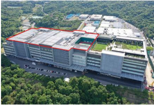
桑畑工場 太陽光発電システム
